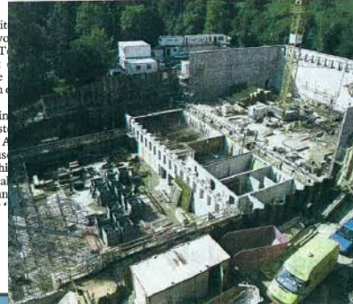
Imposant und eindrücklich ist die Baustelle der neuen Turnhallen.
